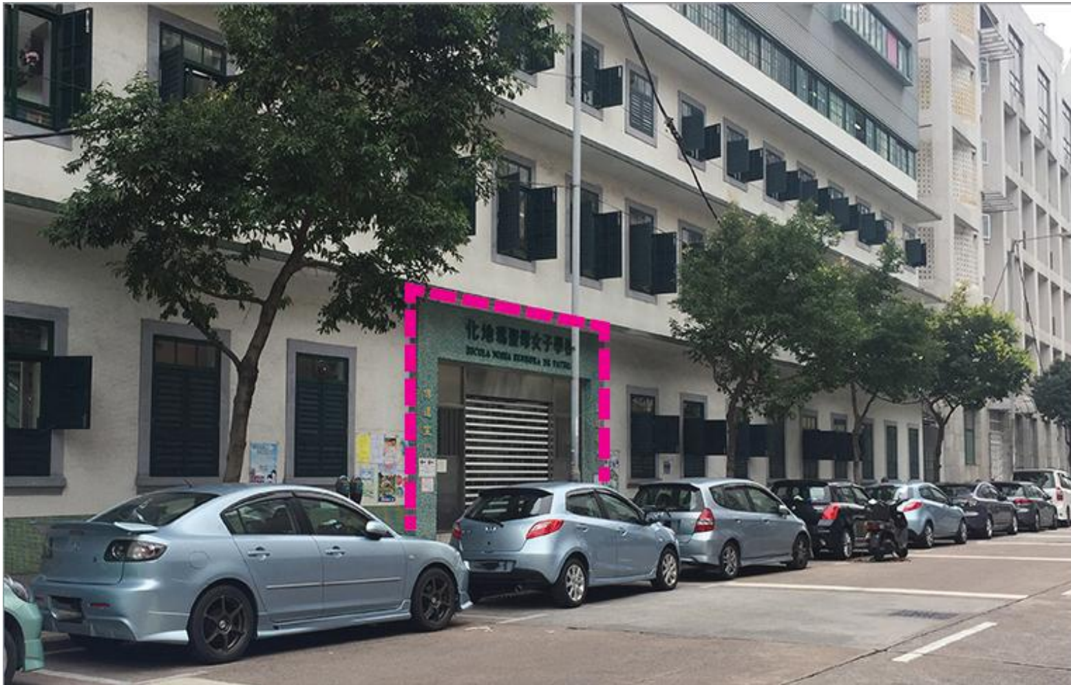
化地瑪聖母女子學校，澳門台山花地瑪教會街（由李寶椿街的校門進入） Escola Nossa Senhora de Fátima, sita na Rua da Missão de Fátima, Macau (entrada pelo portão da escola, na Rua de Lei Pou Chon)
